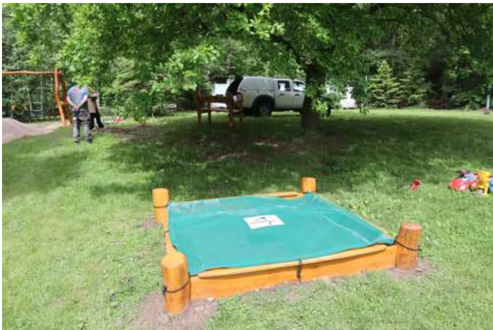
Dokončení nového pískoviště
