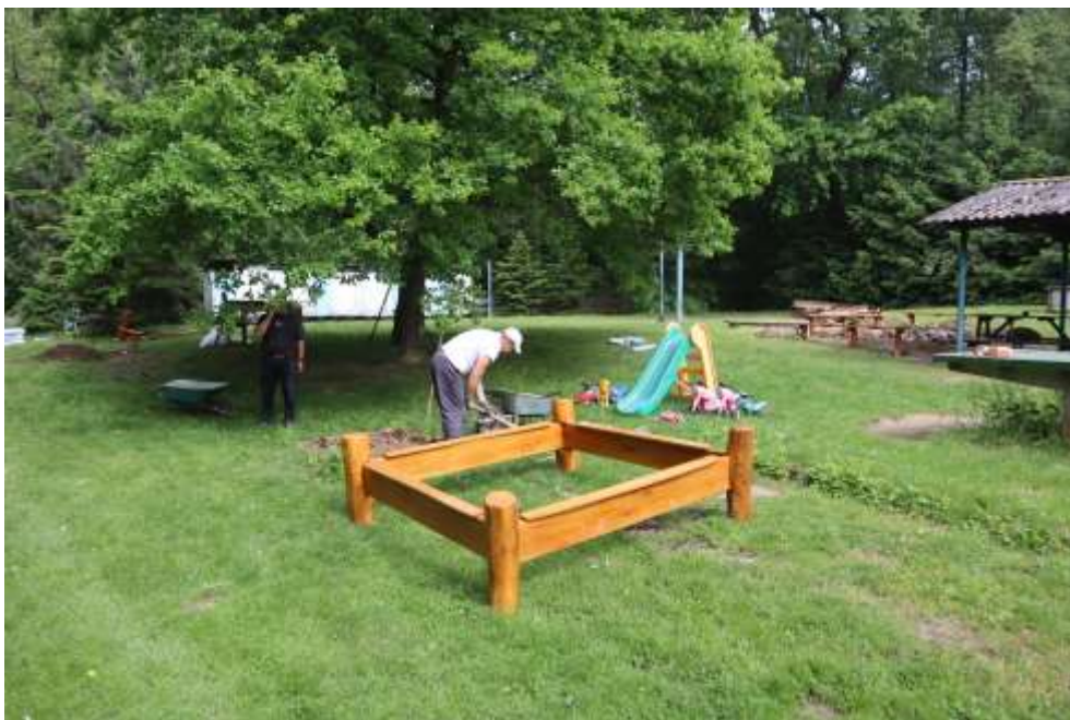
Výkopové práce pro nové pískoviště
