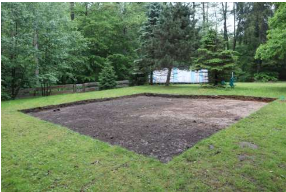
Dokončení výkopových prací pro dopadovou plochu dětského hřiště
