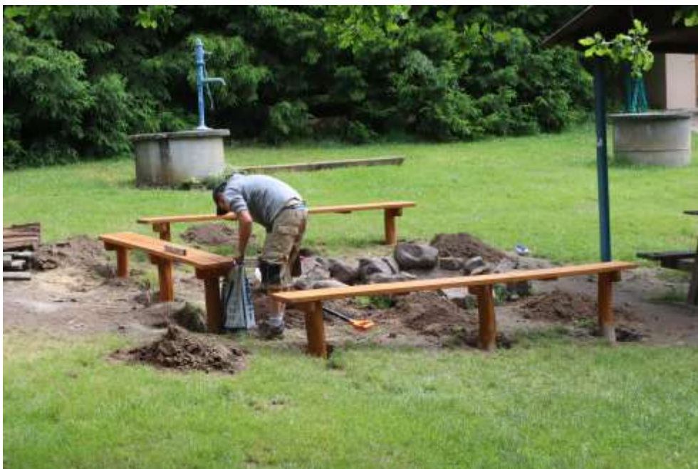
Instalace nového sezení okolo ohniště
