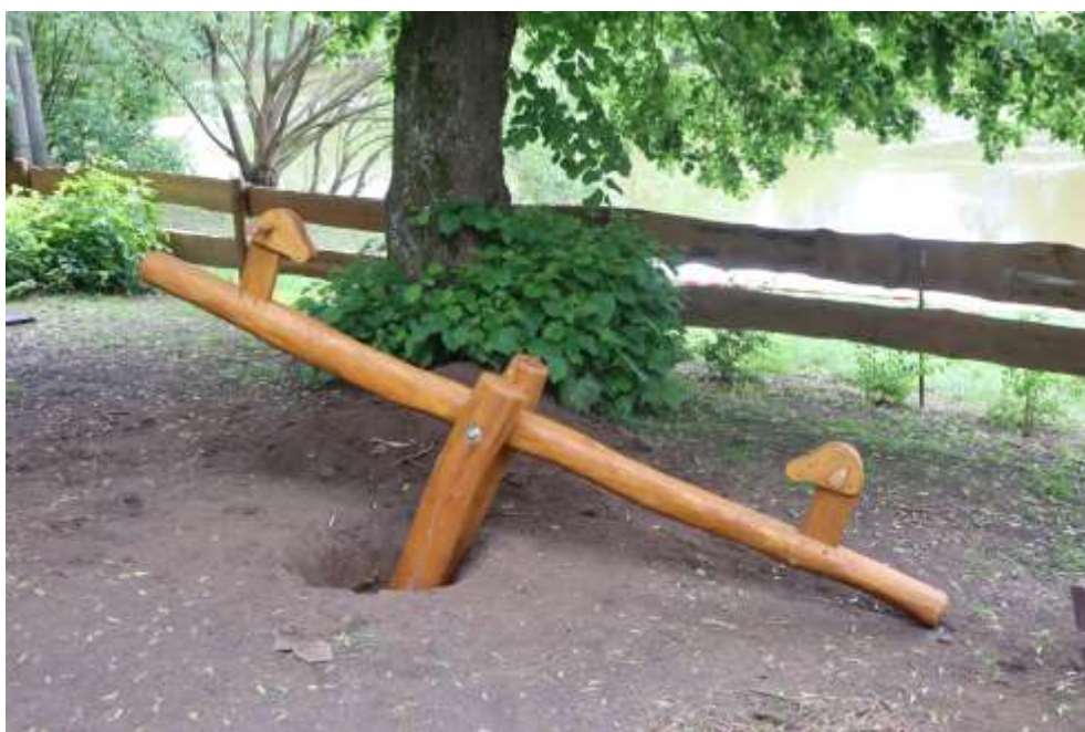
Instalace nové houpačky v areálu Baštírny
