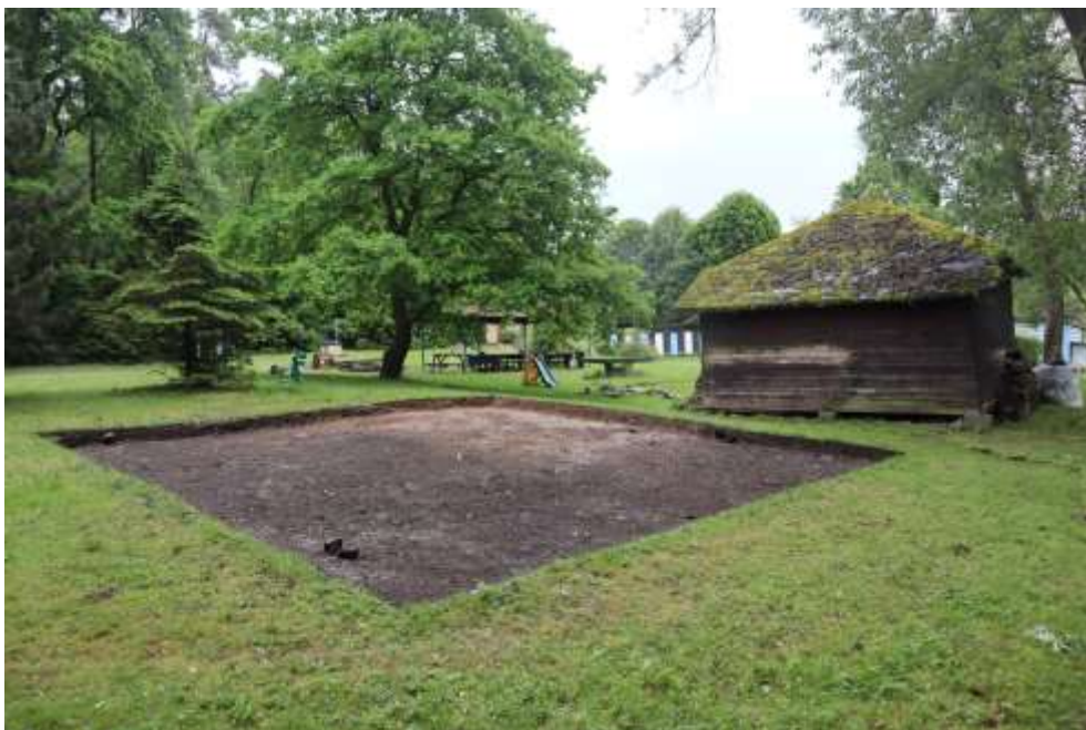
Dopadová plocha připravena pro výstavbu nového dětského hřiště
