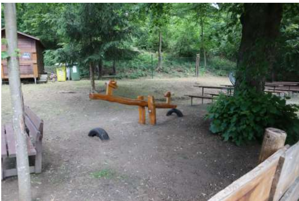
Dokončení instalace nové houpačky v areálu Baštírny
