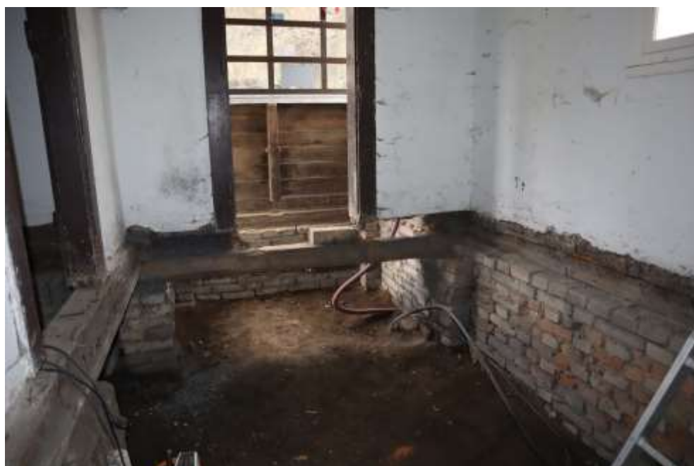
Přední místnost po vyčištění nepořádku pod podlahou
