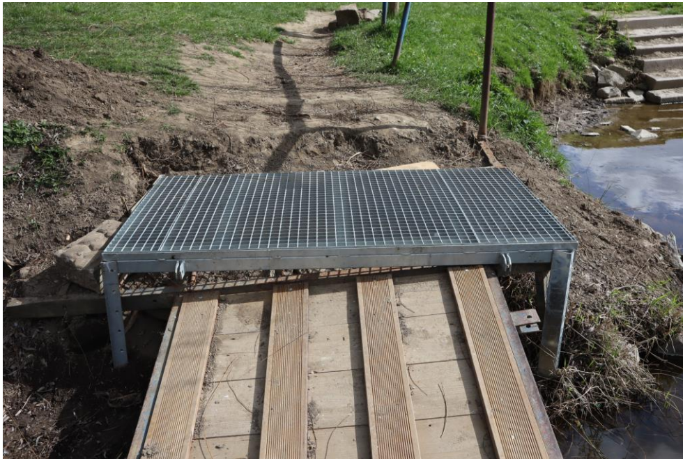
Osazení nového nájezdu
