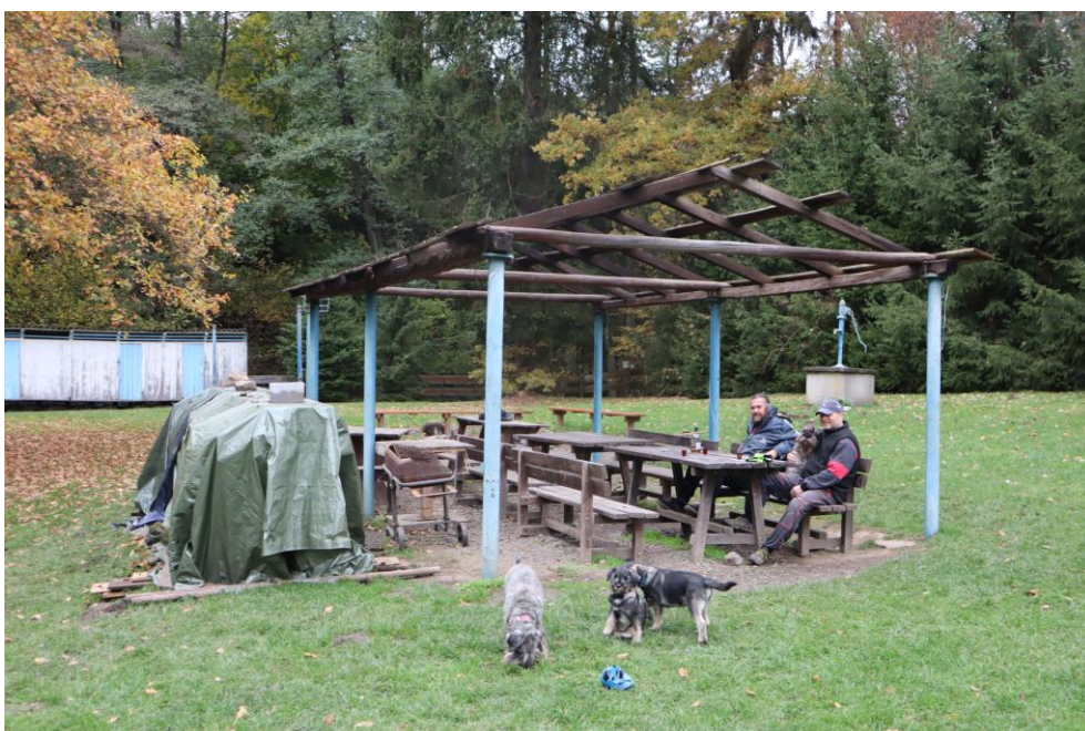
Hotovo – azbestová střecha zlikvidována
