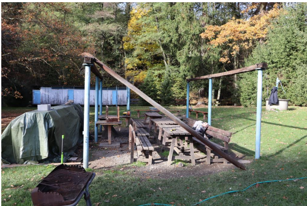
Střecha postupně mizí
