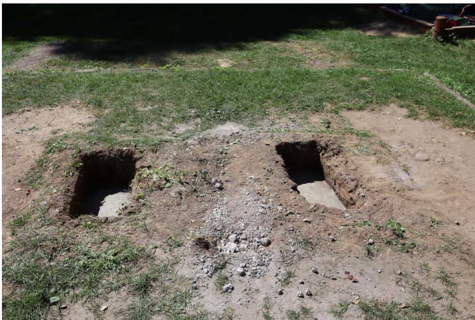
Vyhloubení a betonáž nových základových patek
