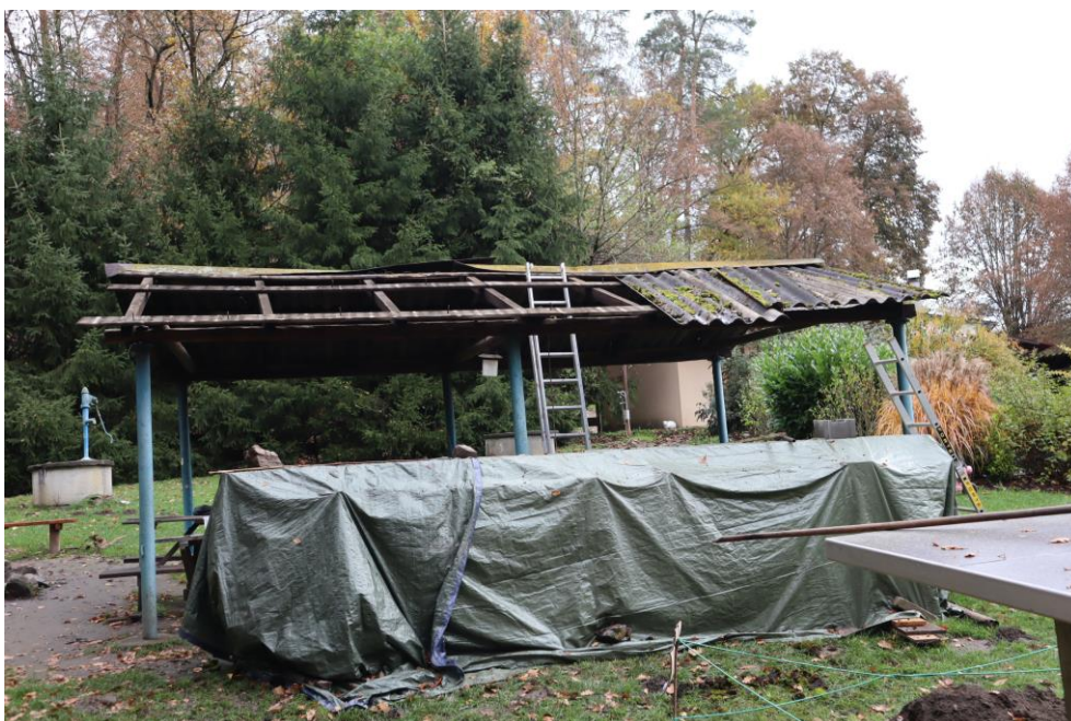
Postupné rozebírání střechy
