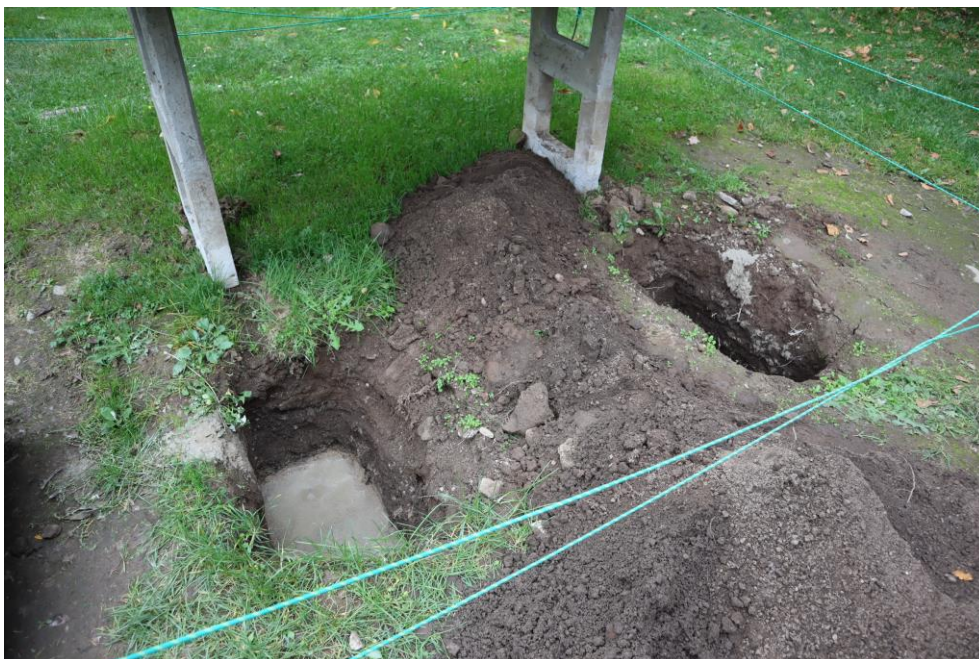
Nové betonové patky – snad již ve správné výšce
