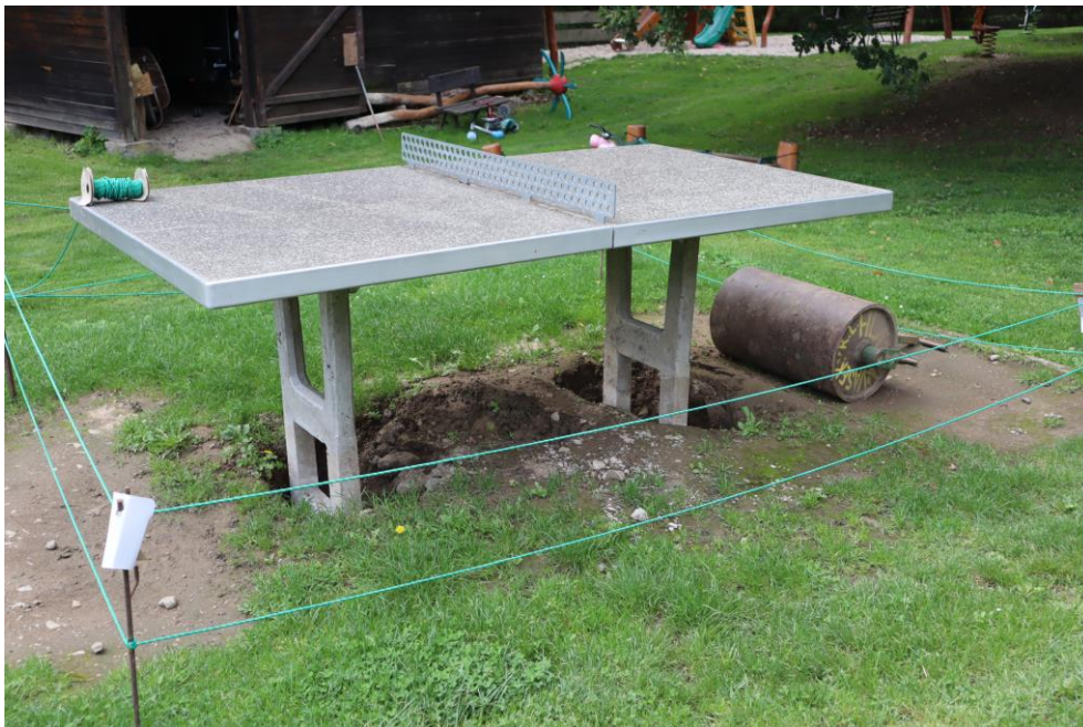
Usazení ping-pongového stolu na místo
