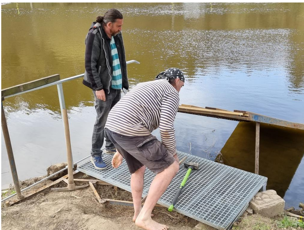
Následné usazení železného roštu a zábradlí
