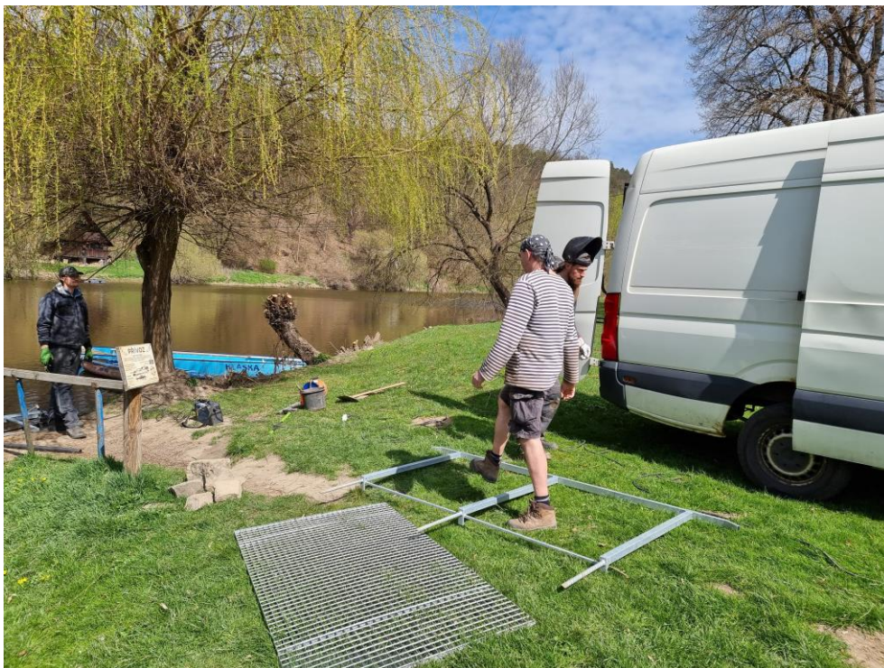
Pracovníci společnosti ROKA PLUS s.r.o. při finální instalaci nového nájezdu
