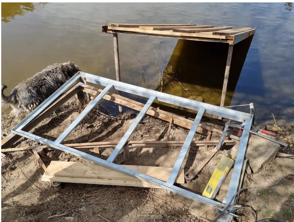
Svařování železné konstrukce
