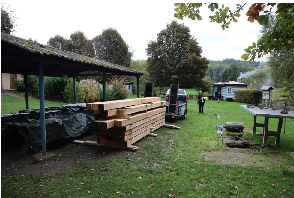
Připraveno na novou stavbu
