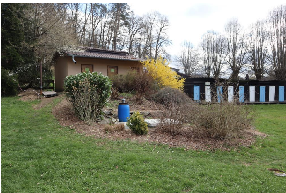
Úprava keřů a travin v okolí čističky
