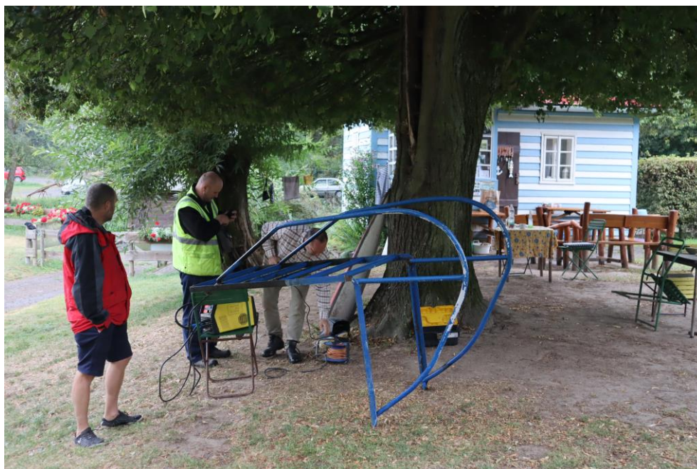
A svařování schůdků do vody
