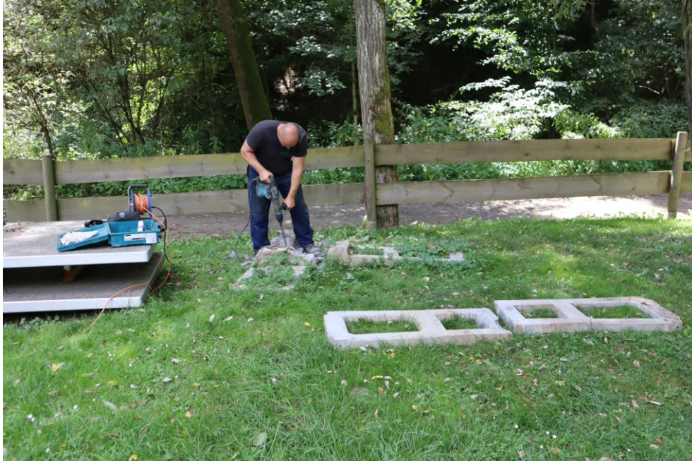
Příprava nového stolu k osazení
