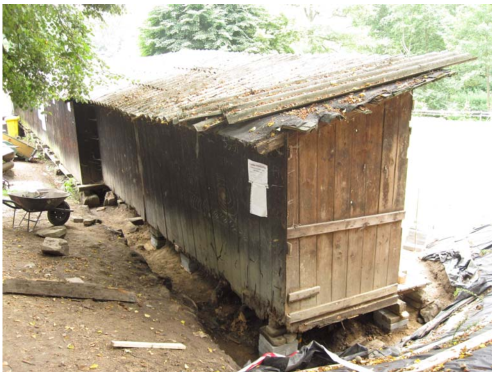
Kabiny jsou podezděny
