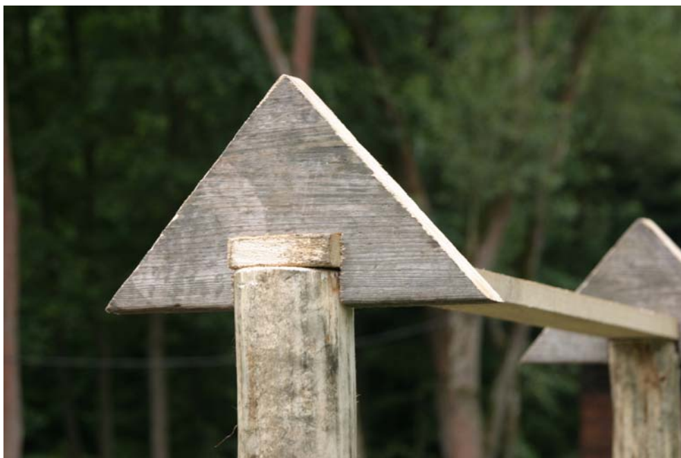
Detail základu stříšky informačního panelu
