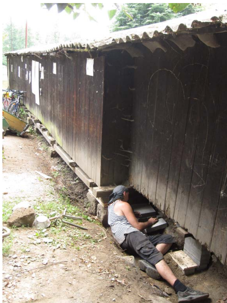
Před zahájením oprav byly dřevěné konstrukce zcela odhaleny, aby mohly vysychat
