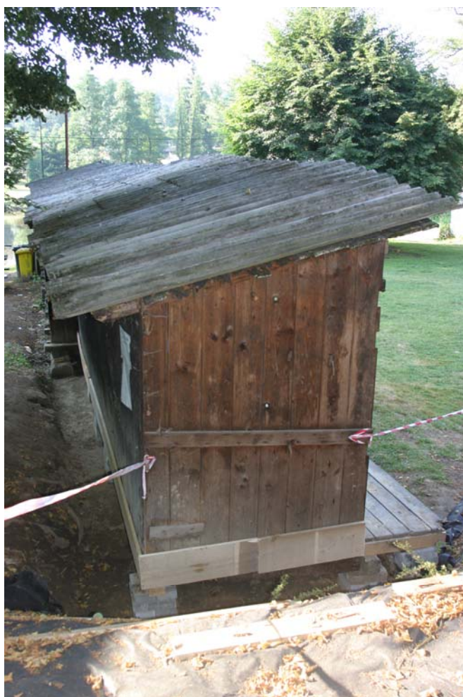
Kabiny jsou podezděny
