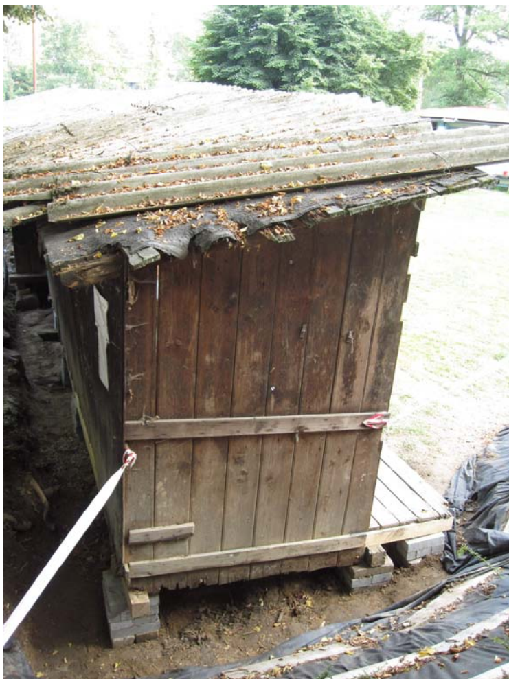
Stavba kabin byla postupně vyheverována do roviny a podezděna
