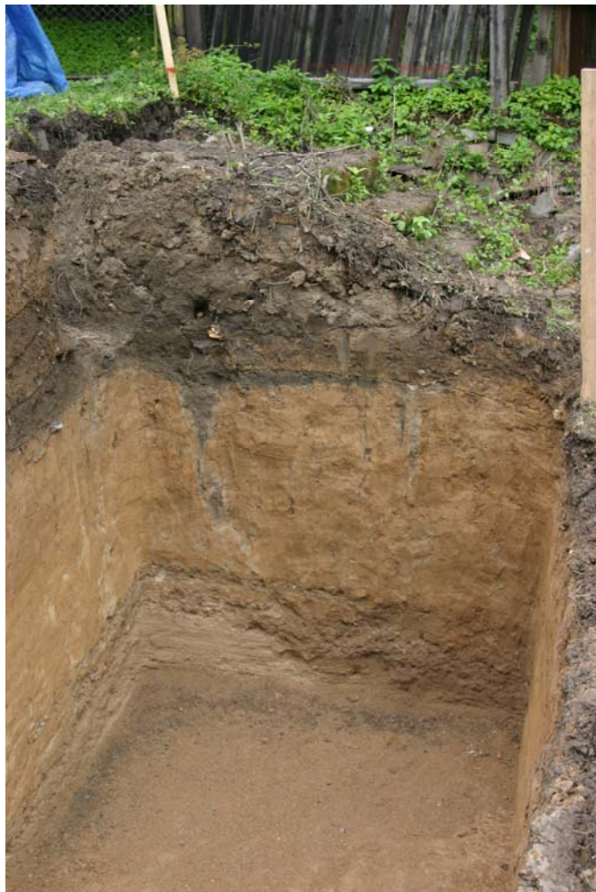
Podobná situace vertikálního řezu výkopem jímky
