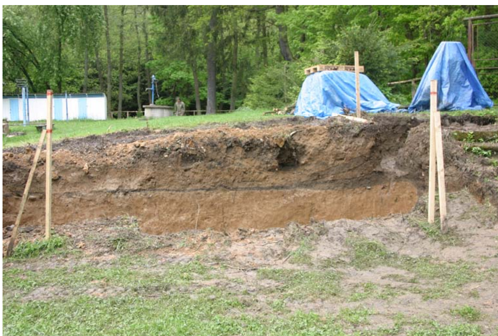
Řez výkopem pro jímku s patrným rozhraním tmavých vrstev souvisejících s existencí plovárny (nahore) a žlutých povodňových náplavů
