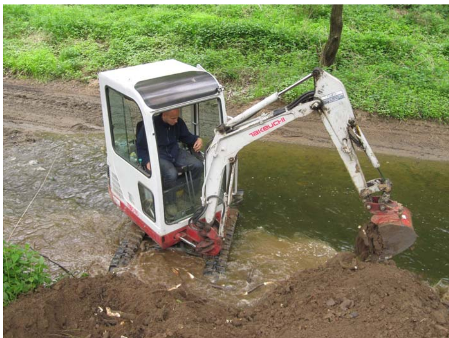
Úprava vyústění kanalizace do potoka Mnichovky
