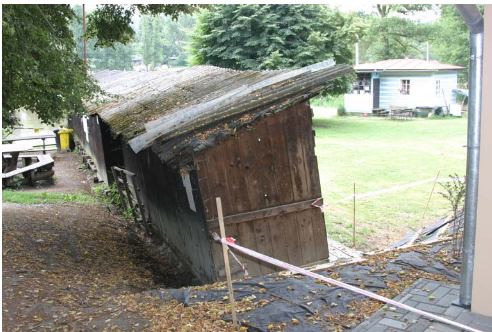
Zadní část kabin byla zcela shnilá a vyžadovala opravu
