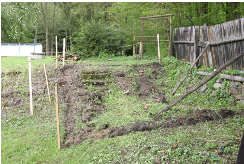
Výkopy pasů pro základy sociálních zařízení
