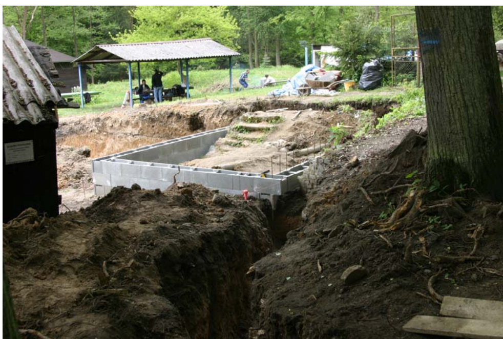
Základy sociálního zařízení s vykopanou přípojkou k občerstvení Baštírna
