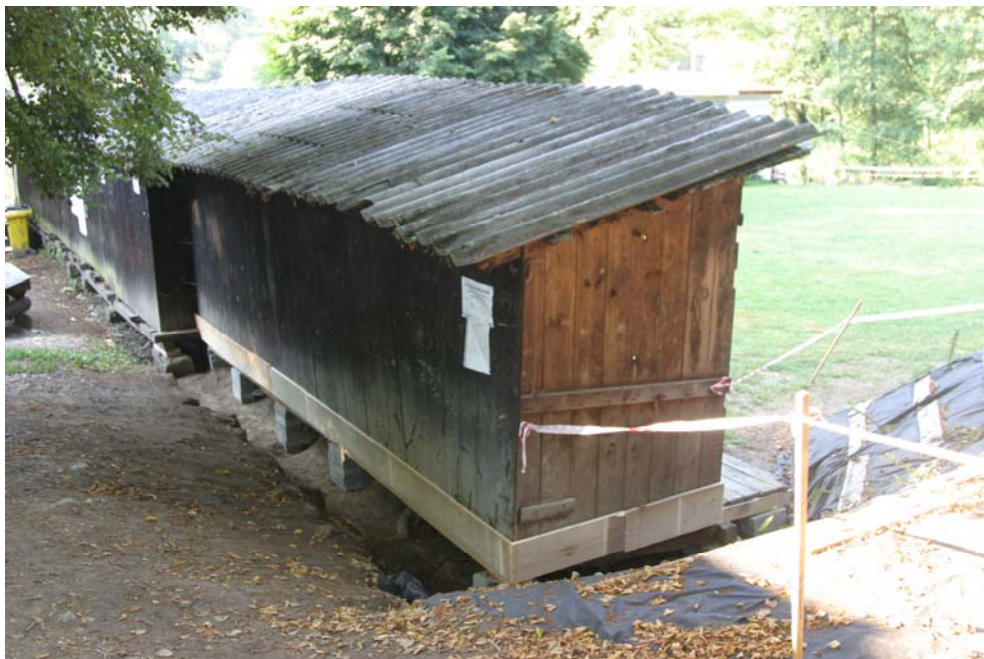
Oprava základového roštu kabin byla dokončena
