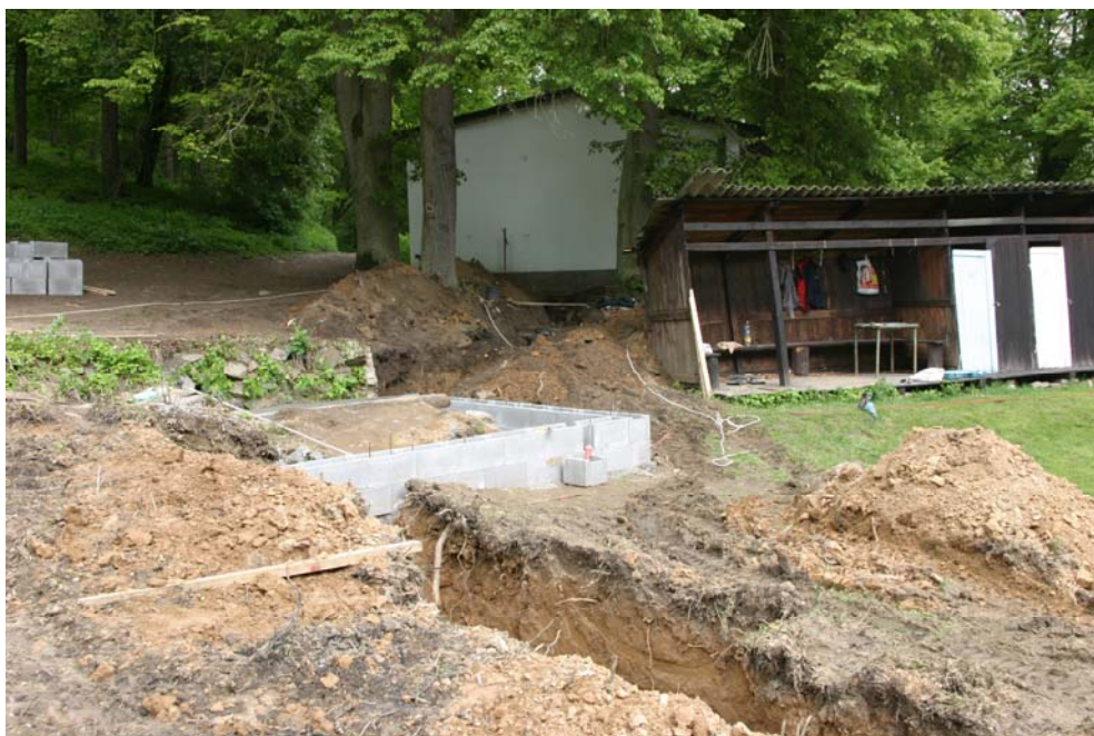
Základové pasy sociálního zařízení
