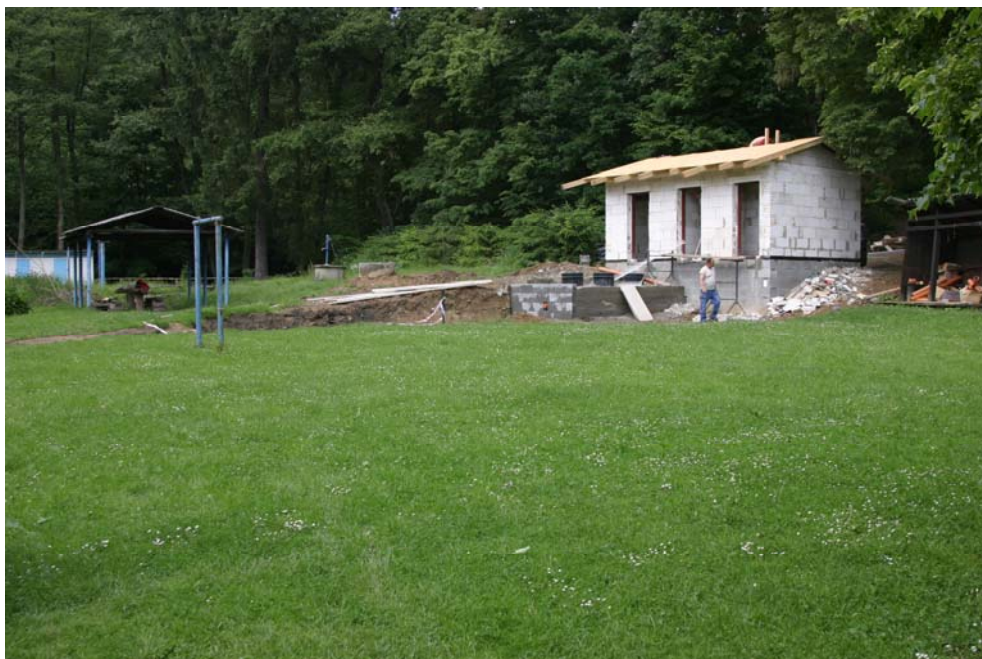
Hrubá konstrukce záchodů je hotova
