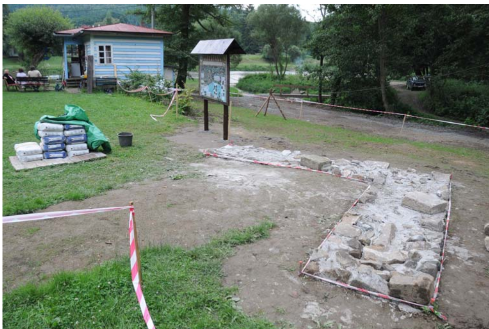
Rekonstrukce nároží pozdně středověkého domu
