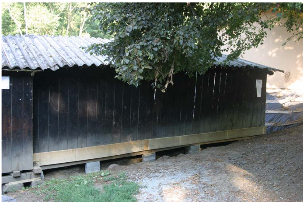
Opravený konec lázeňských kabin
