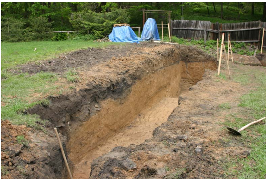
Výkop pro jímku a zemní filtr
