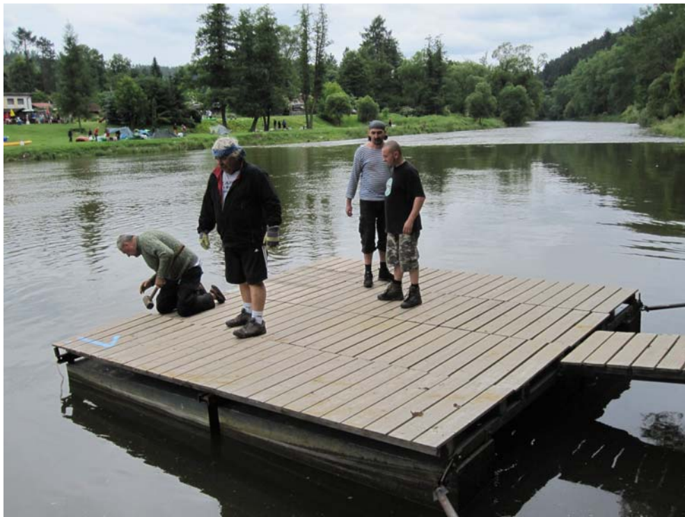
Ponton je spuštěn na vodu
