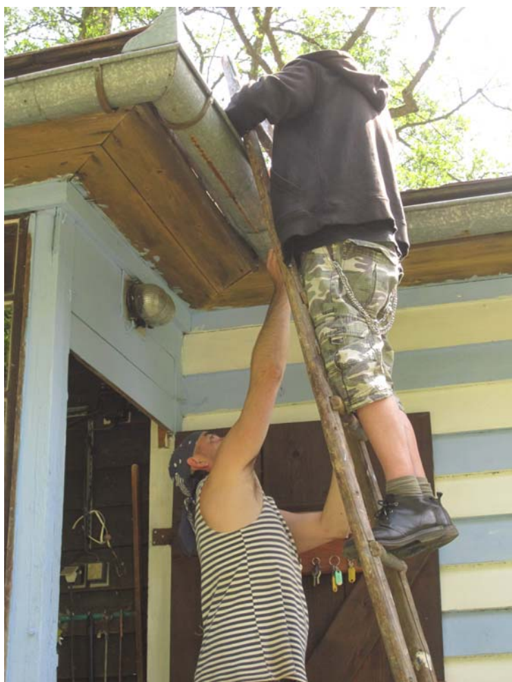
Tmelení prorezlého okapu
