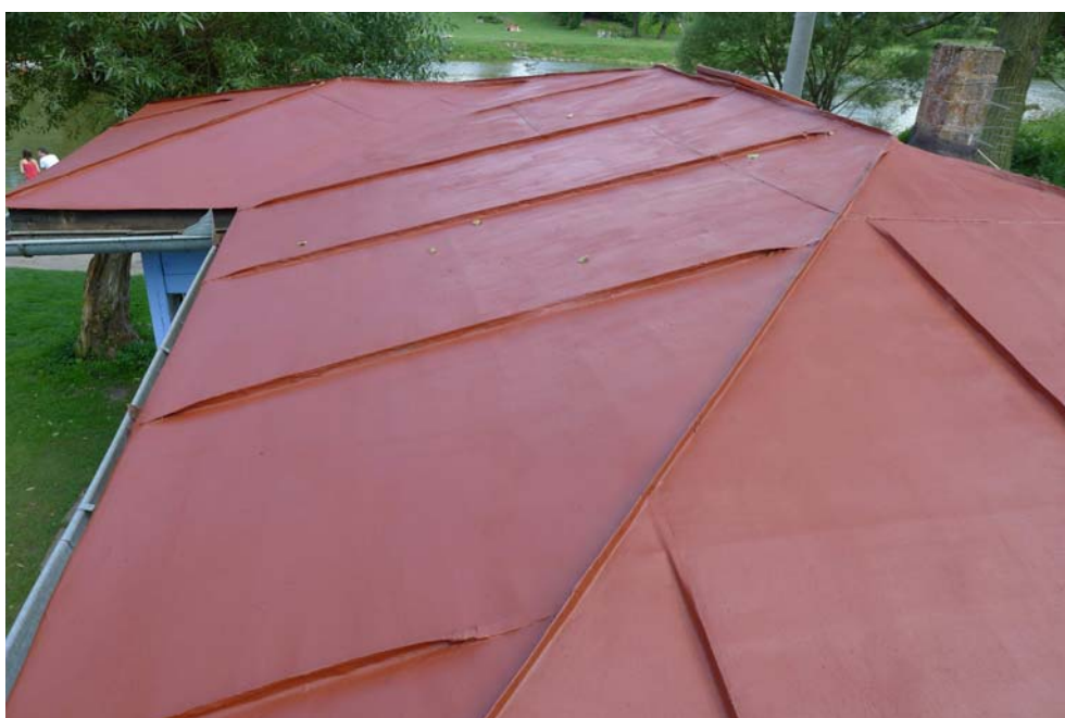
Nový nátěr střechy
