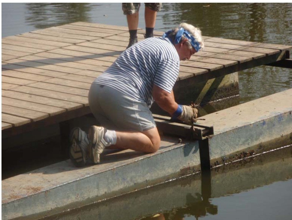
Demontáž zrezivělých plováků
