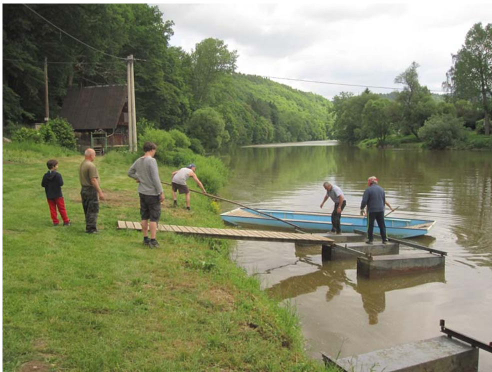
Instalace nástupu na vorek
