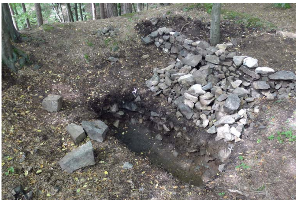
Na černo vyhloubená sonda na hradě byla zdokumentována
