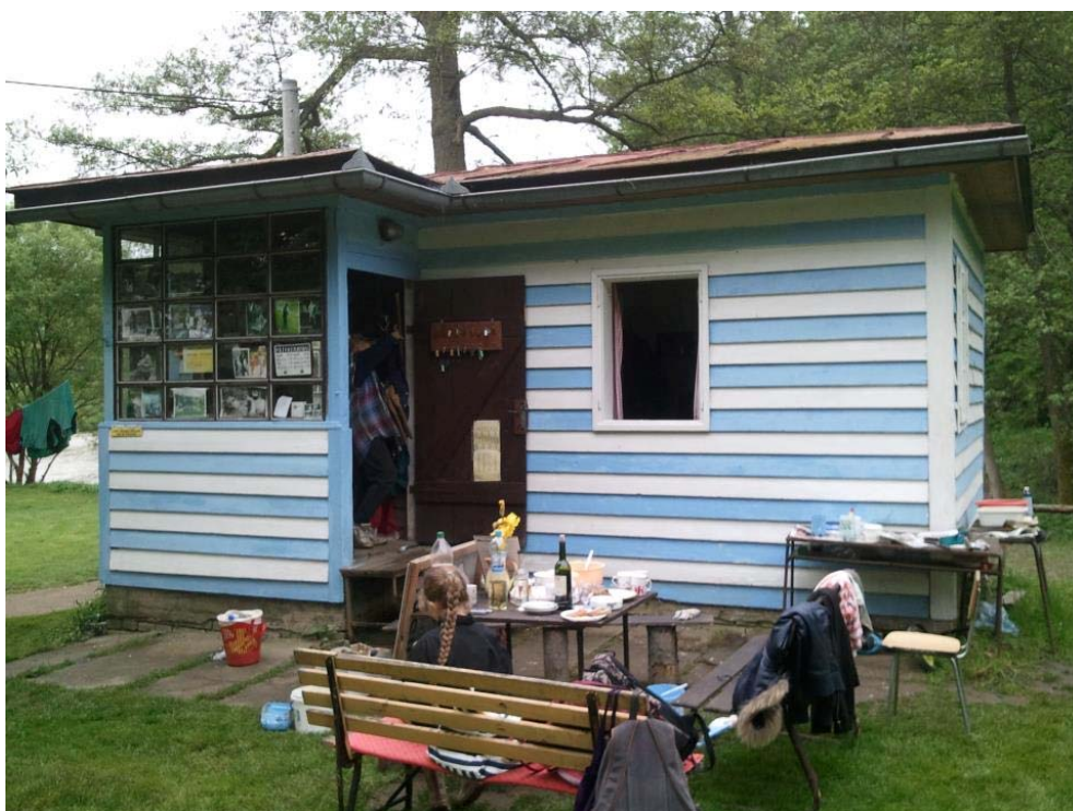
Nový nátěr dostala část převoznického domečku
