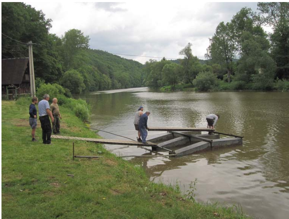
Náročné osazovanie dřevěných podlažek na pontony
