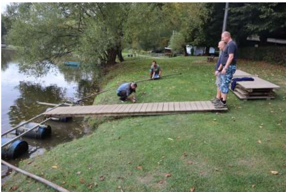
Nové koupací molo bylo vyzvednuto z vody
