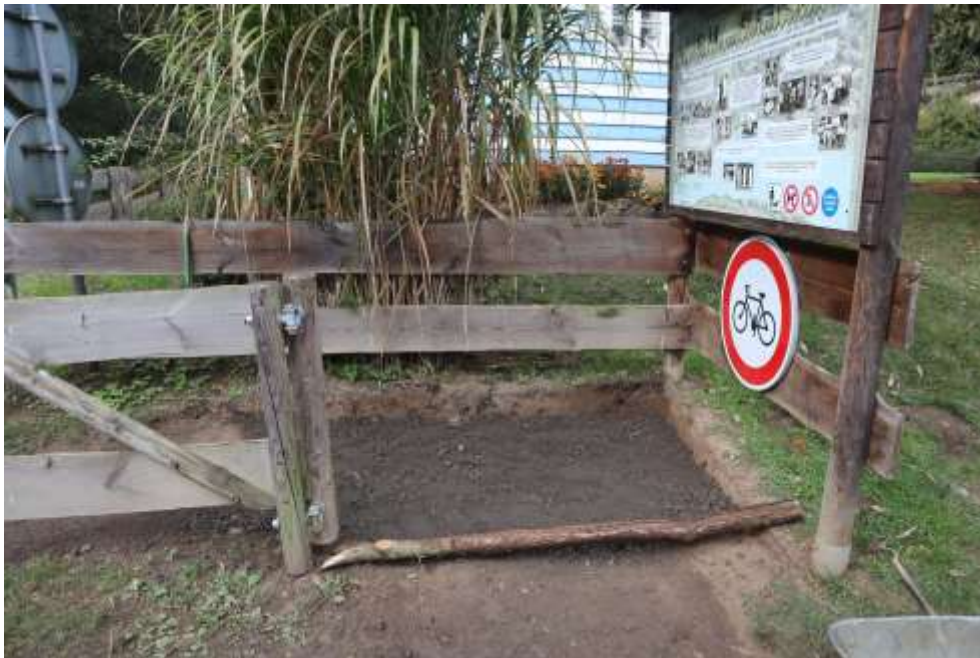
Štěrkový podsyp dokončen
