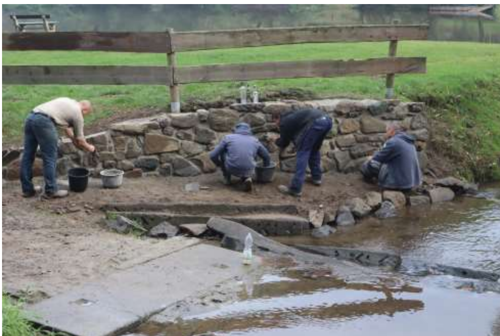
Spárování nové tarasní zdi
